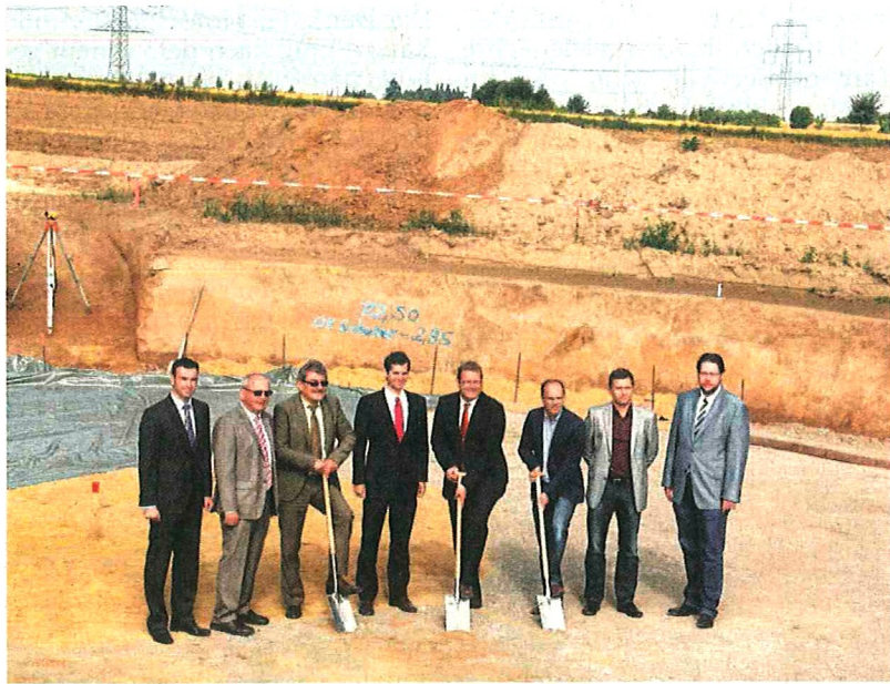
Die beteiligten Projektpartner in der Baugrube: Bei Tripsrath entsteht eine Windparkanlage mit drei Windrädern. Foto: Georg Schmitz
