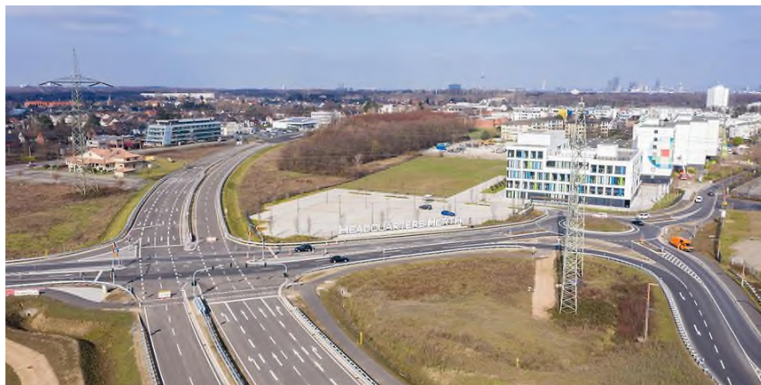
Eine Luftaufnahme der Ortsumgehung B 265n Foto: Uwe Weiser
