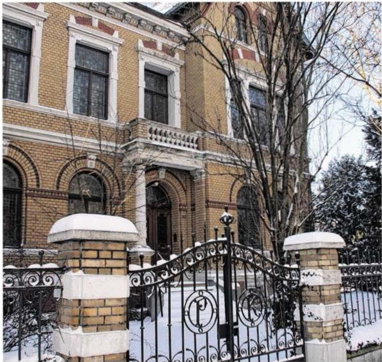
Rund um die denkmalgeschützte Villa an der Bonner Straße herum will der Verein zur Förderung der Caritasarbeit im Bistum Aachen 20 seniorengerechte Wohnungen errichten. Foto: Johnen
