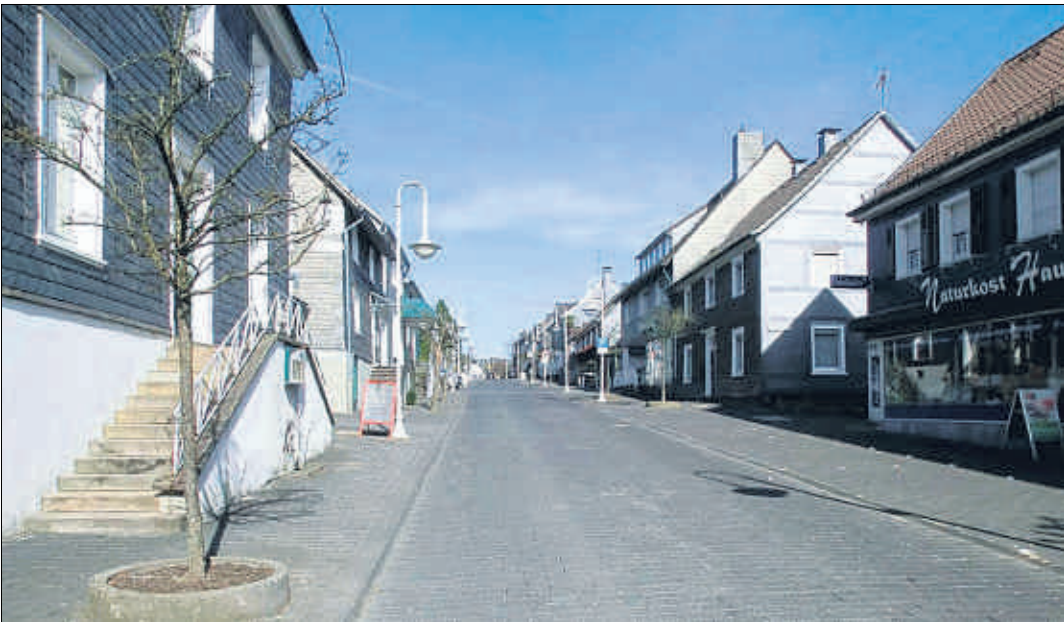
So präsentiert sich die Nümbrechter Hauptstraße zurzeit. Für Fußgänger, insbesondere Menschen mit Kinderwagen, oder Rollstuhlfahrer sind die Bürgersteige verbaut. (Foto: Planungsgruppe MWM)
